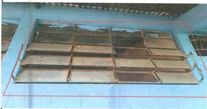
Foto 3: Insalacion de ventanas en mal estado en el segundo modulo del establecimiento, a ventanas corredizas de pvc color blanco .
