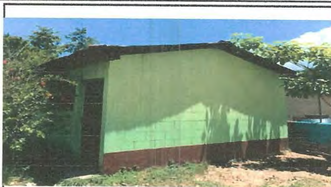
Foto 2: mejoramiento de techo al modulo de cocina.
