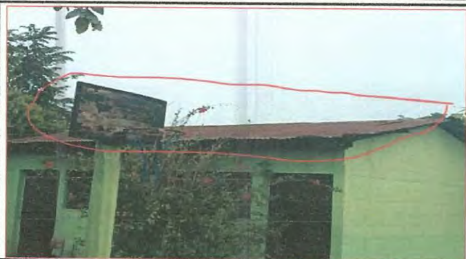
Foto 1: Mejoramiento de techo con lamina troquelada calibre 26 al modulo de cocina
